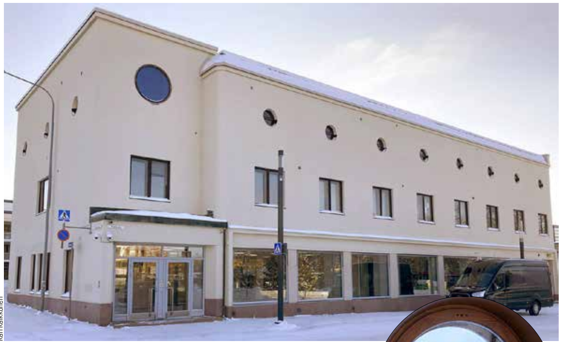
Entisen Nordean kiinteistön peruskunnostus valmistuu helmikuun loppuun mennessä.
