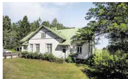
Pertunmaa, Ruorasmäki | Vapaa-ajan asunto 201,5 m 2 Joutsantie 1037. 5h, k, psh, pkh, 3 wc, aula, ullakko. Ei lain ed. e-tod. Hirvivuori/Heinola. Mh. 100.000 € | 648144
