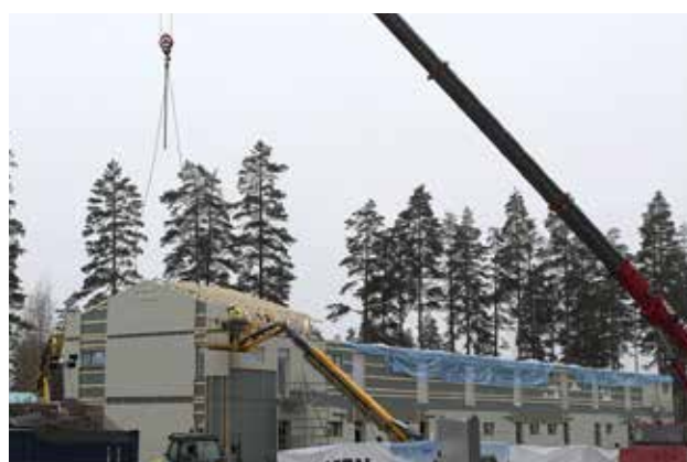
Holiday Clubin kolmannen rivitalon rakennustyöt ovat alkaneet ja neljännen rakennuslupa on jätetty.
