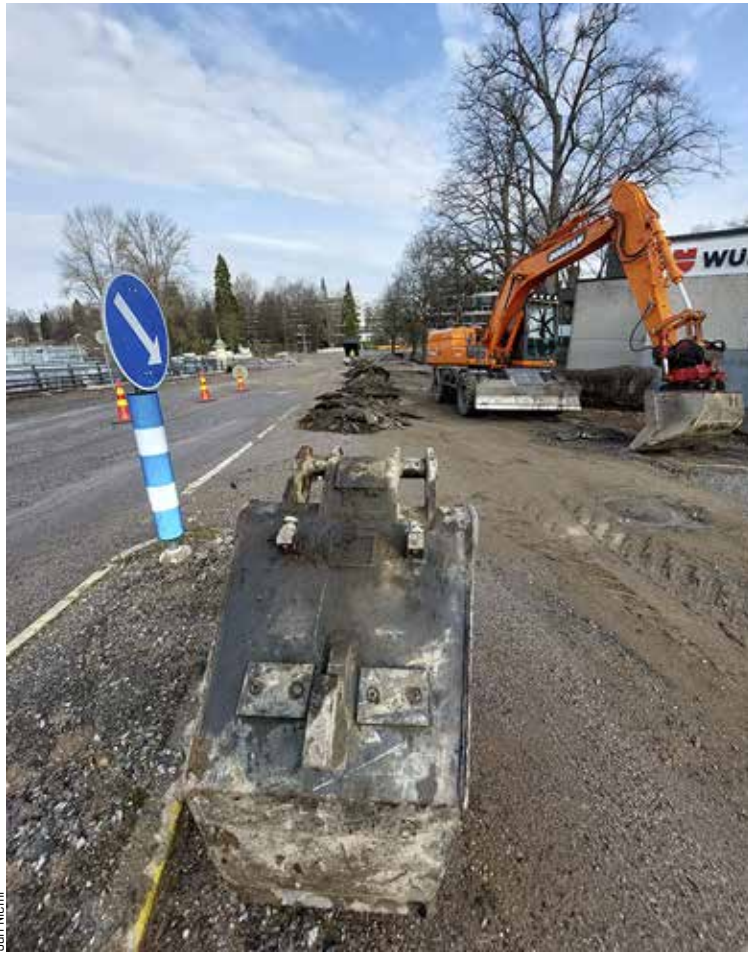
Kaivokadun rakennustöissä oli talvella parhaillaan useita kaivinkoneita.
