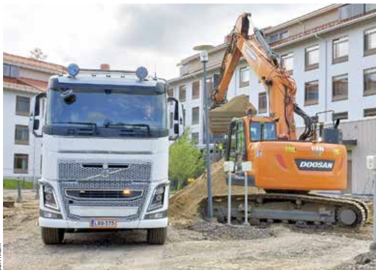
Kylpylän työt alkoivat heinäkuun lopulla maansiirtotöillä.
