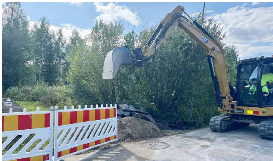
Valokuituverkon rakennustyöt täydessä vauhdissa Heinolan kirkonkylällä elokuussa 2023.
