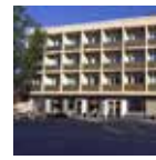
Jyränköläkoti (1963) Siltakatu 11 B 050 590 7083
